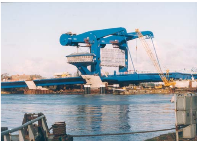
Klappbrücke Wolgast im geschlossenen Zustand
