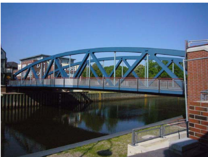
Überbau als Fachwerk im abgesenkten Zustand
