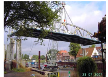
Einhub mit Schwimmkran
