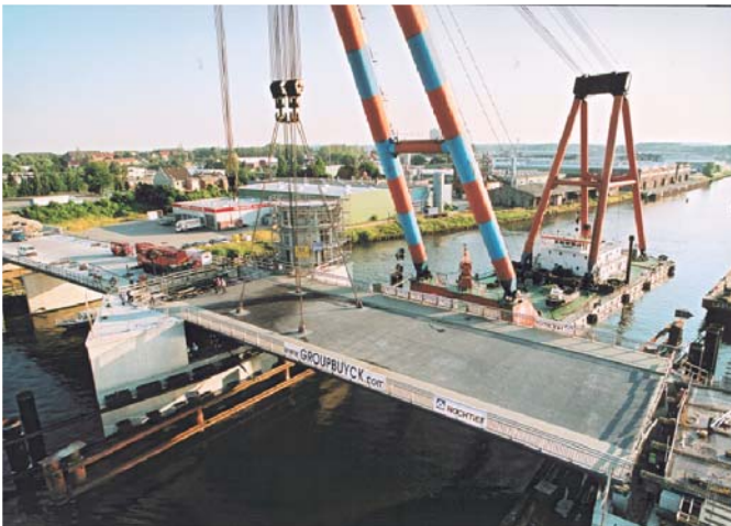
Einhub mit Schwimmkran
