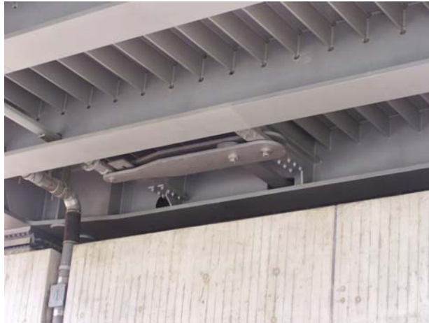
Ansicht Bremslagerung
