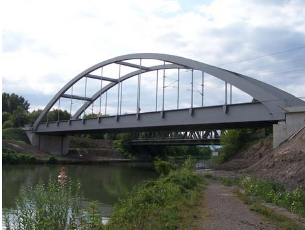
MLK-Brücke Misburg - Ansicht
