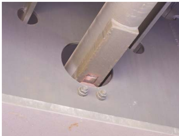
Allseits bewegliches Lager an der Durchdringung des QT
